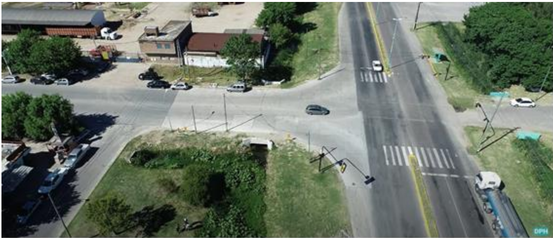
Imagen 3: Vista inversa a la anterior de camino Humet y Mosconi donde se observan las obras accesorias preexistentes.
